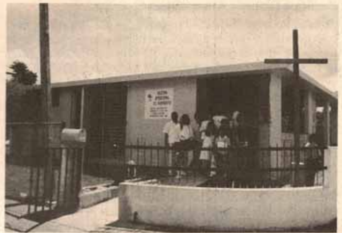
Nuevas facilidades de la Iglesia El Adviento, Villa Fontana, Carolina, P.R.
